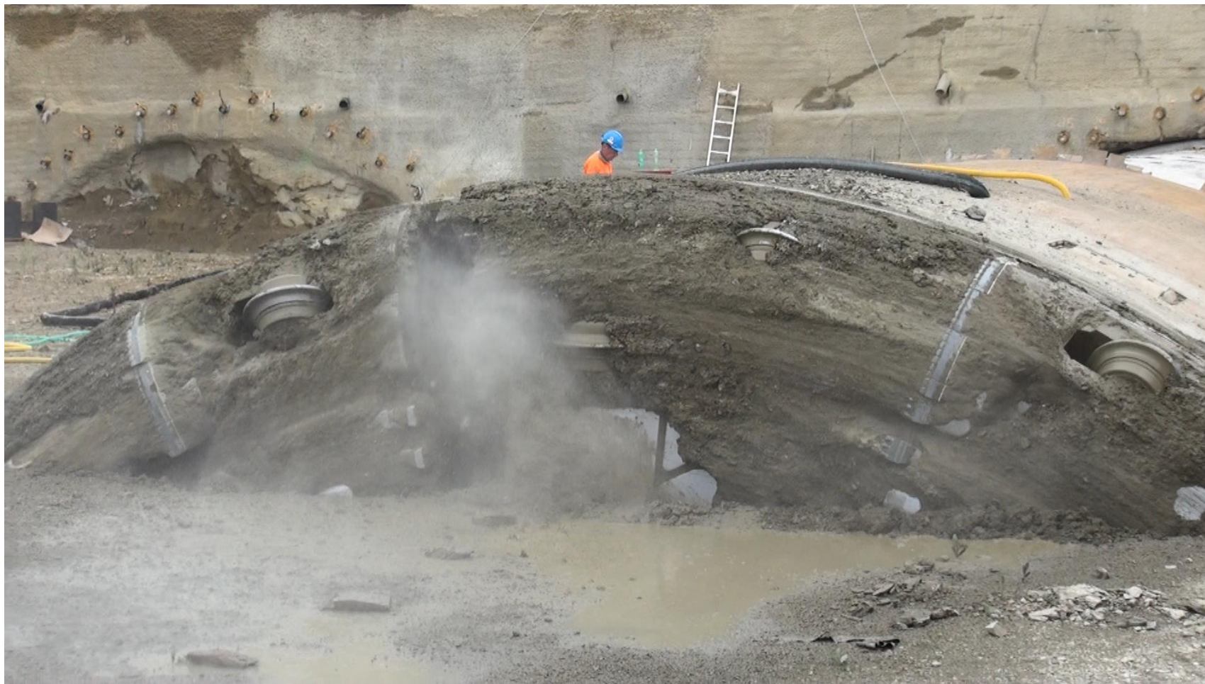
Ražba posledních metrů Ejpovického tunelu
