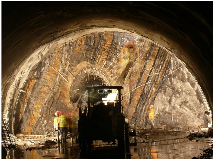
Ražba Bubenečského tunelu v Praze
