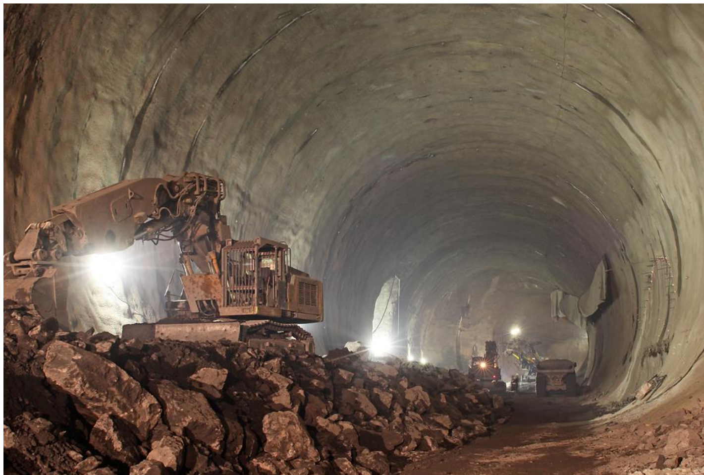
Ražba strojovny vzduchotechniky Bubenečského tunelu v Praze
