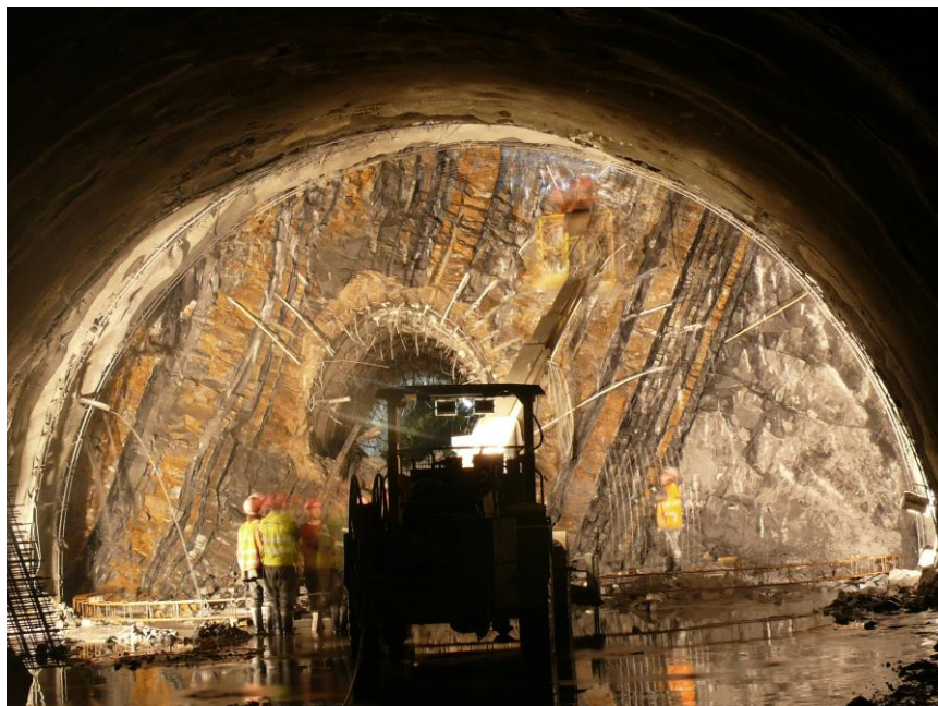
Ražba Bubenečského tunelu v Praze
