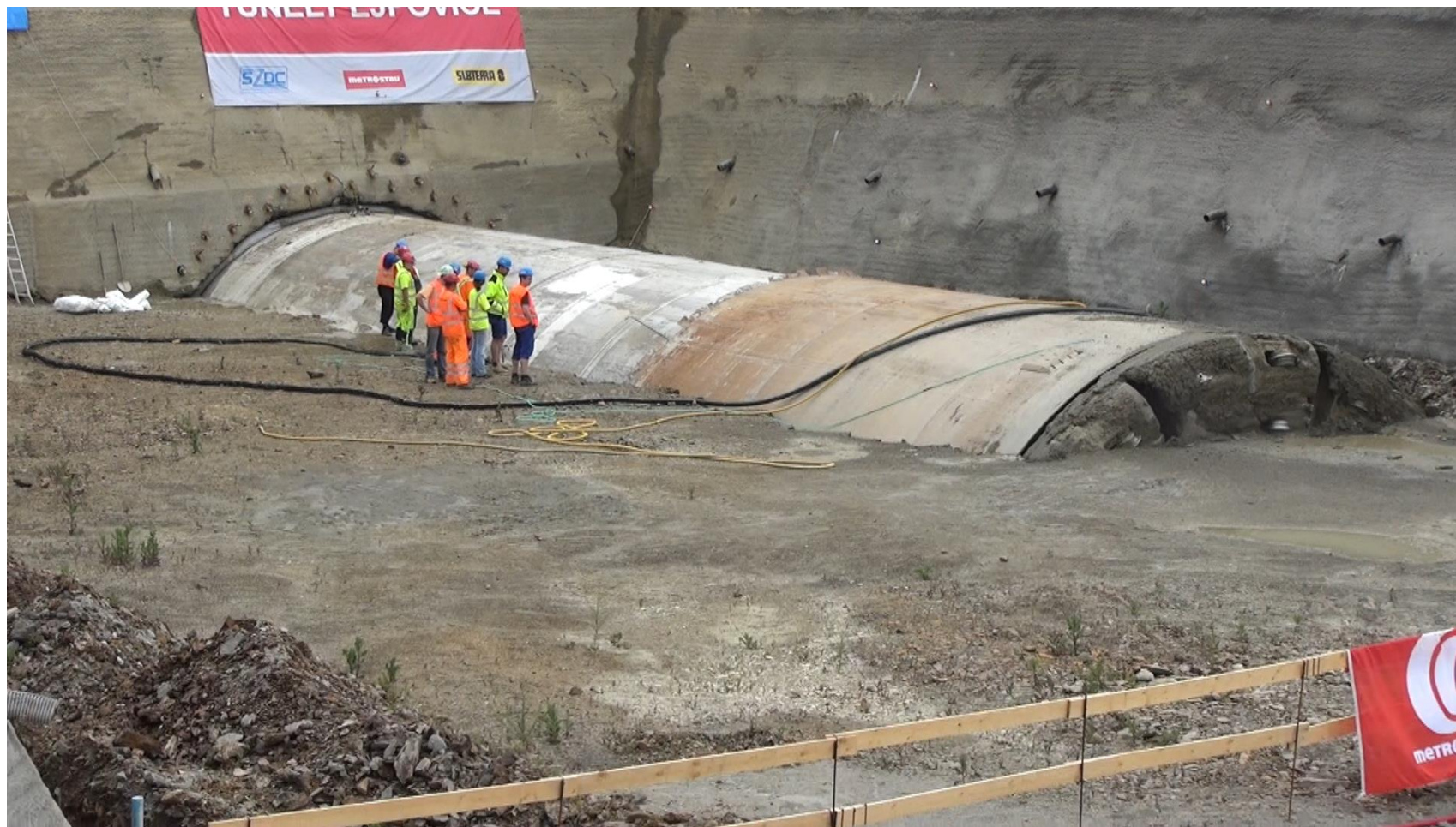
Ražba posledních metrů Ejpovického tunelu
