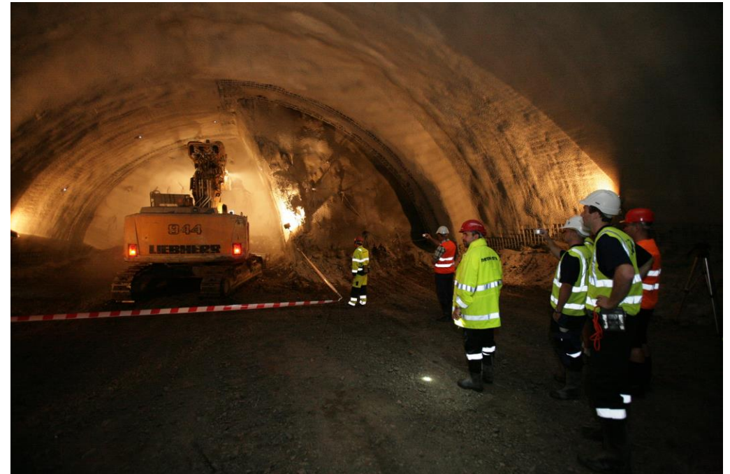
Výkon technického dozoru při ražbě Bubenečského tunelu v Praze
