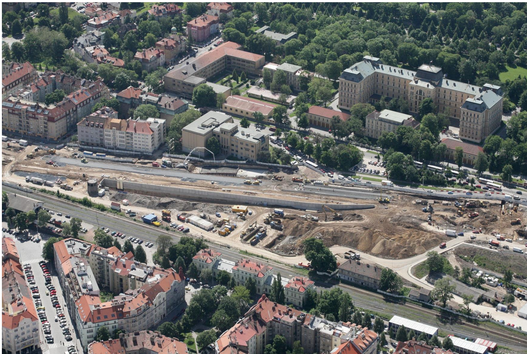
Provádění hloubených tunelů Dejvického tunelu v těsné blízkosti zástavby v ul. Milady Horákové v Praze
