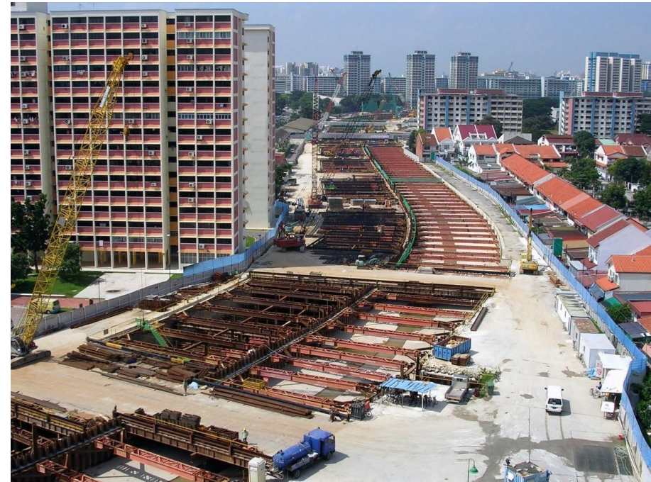
Dočasné protihlukové stěny na projektu Kallang-Paya Lebar Expressway, Singapore
