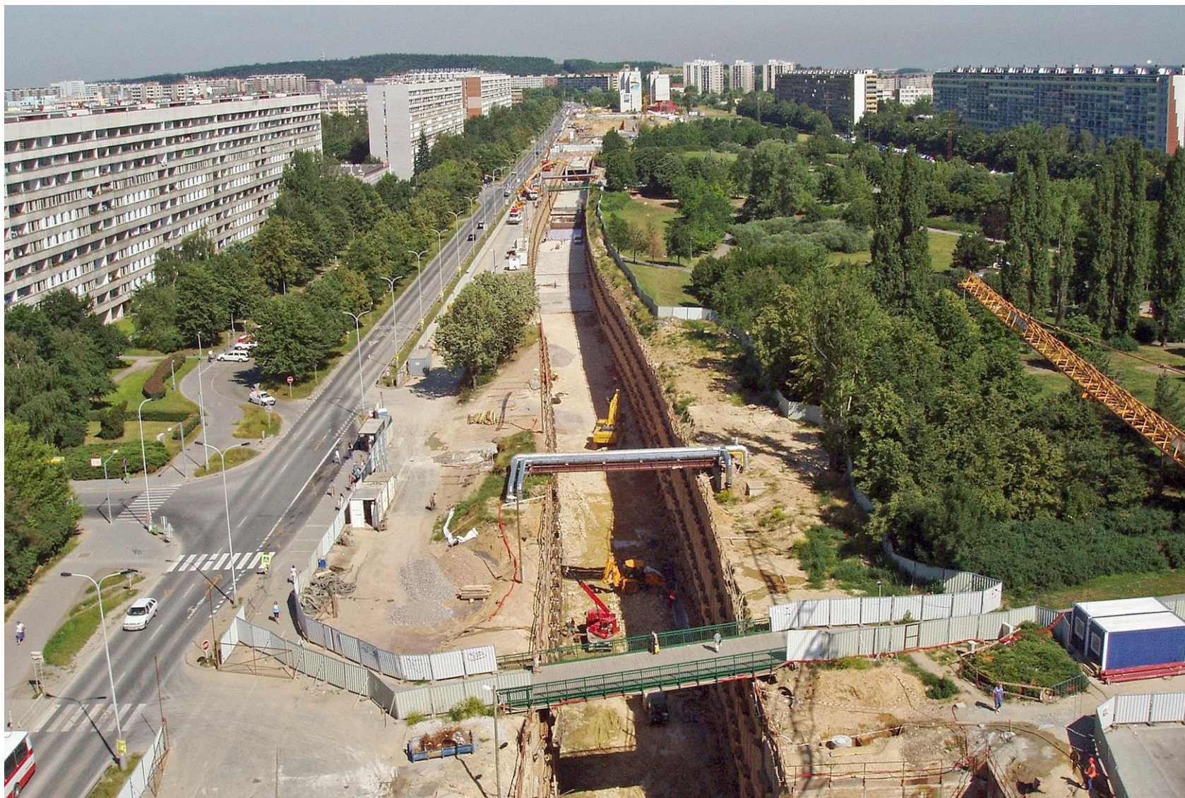
Provádění hloubených tunelů prodloužení trasy metra C na sídlišti Prosek v Praze
