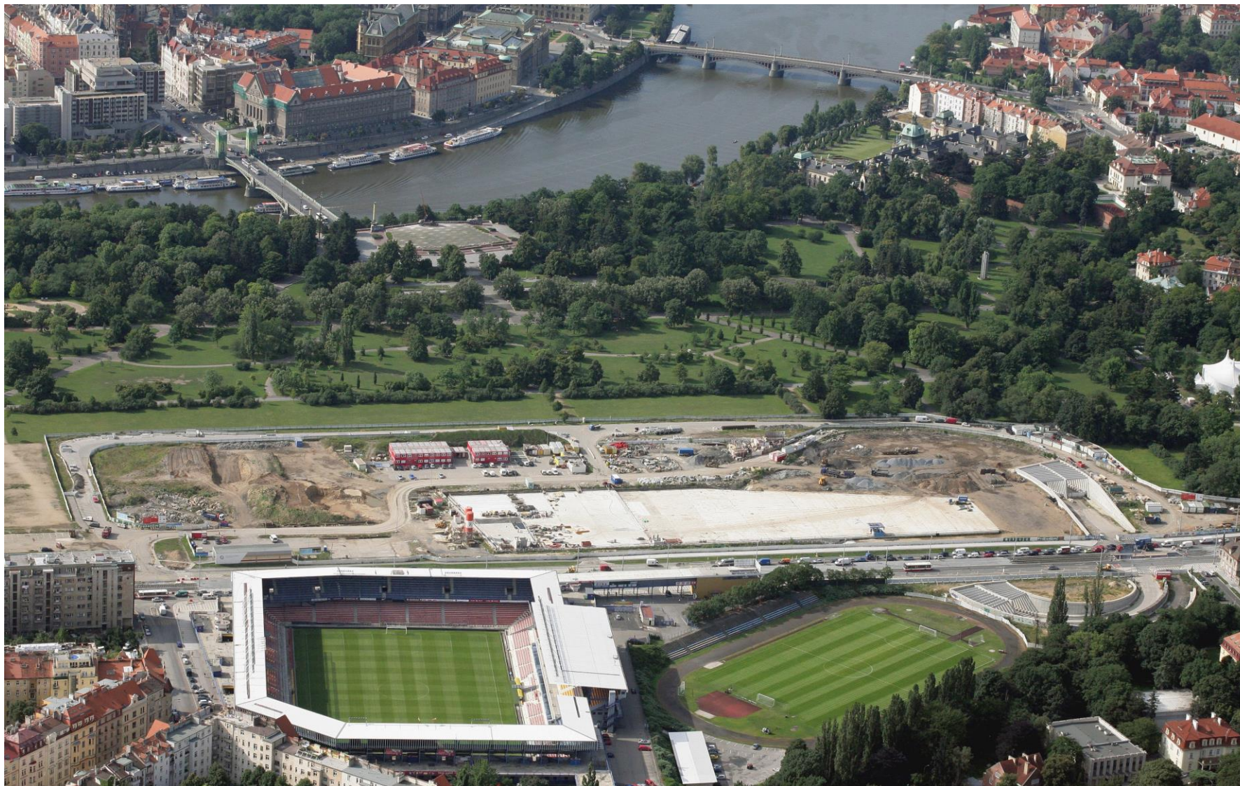
Provádění ražených a hloubených tunelů Bubenečského tunelu v těsné blízkosti parku Letná v Praze
